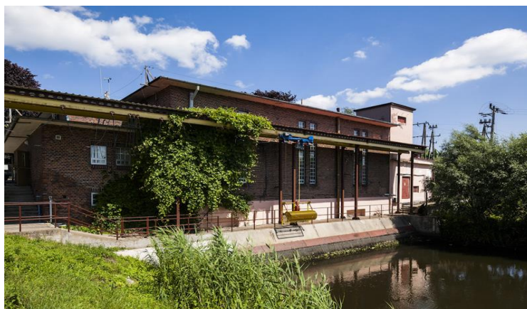
Stacja pomp w Chłodniewie
