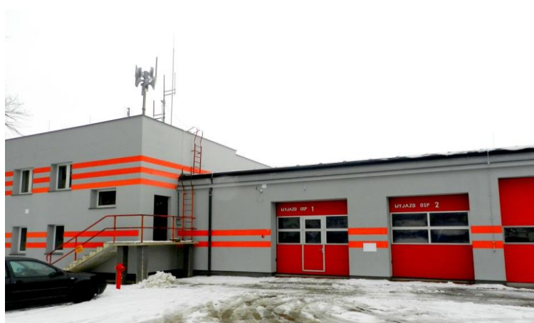
Budynek Ochotniczej Straży Pożarnej w Stegnie
