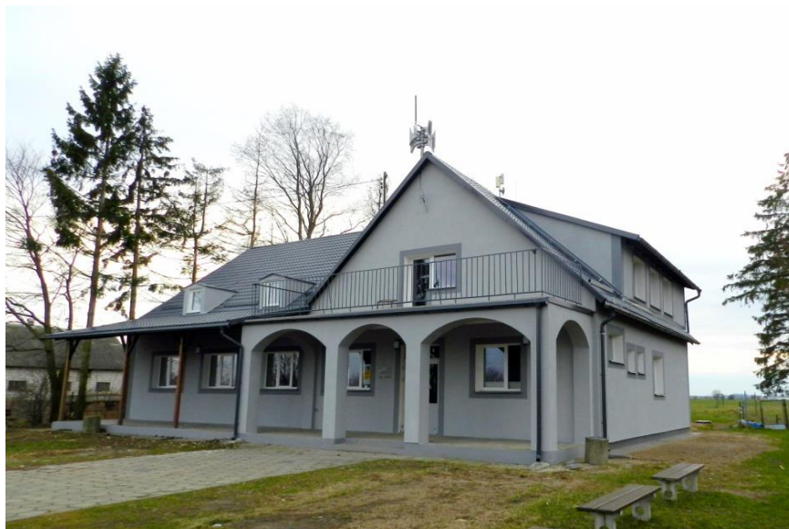
Świetlica wiejska w Bronowie
